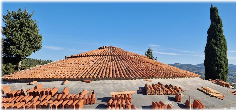
Dopo lunghe ed estenuanti attese, complice anche il caldo estivo, si sta procedendo alla stesura del manto di copertura del tetto della Rotonda. Il termine di questo primo lotto di lavori prevede anche la
